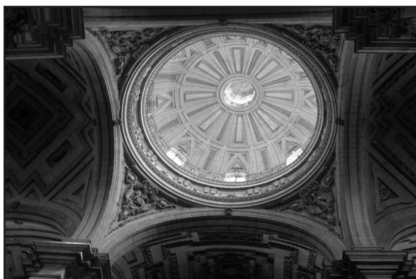
Bóveda elíptica de la Catedral de Jaén, obra de Ventura Rodríguez
