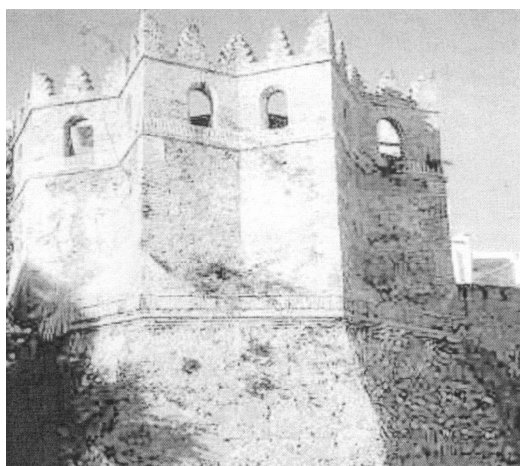
Fig. 1: Bastión poligonal de la muralla de Tetuán, ubicado en el frente Este.
