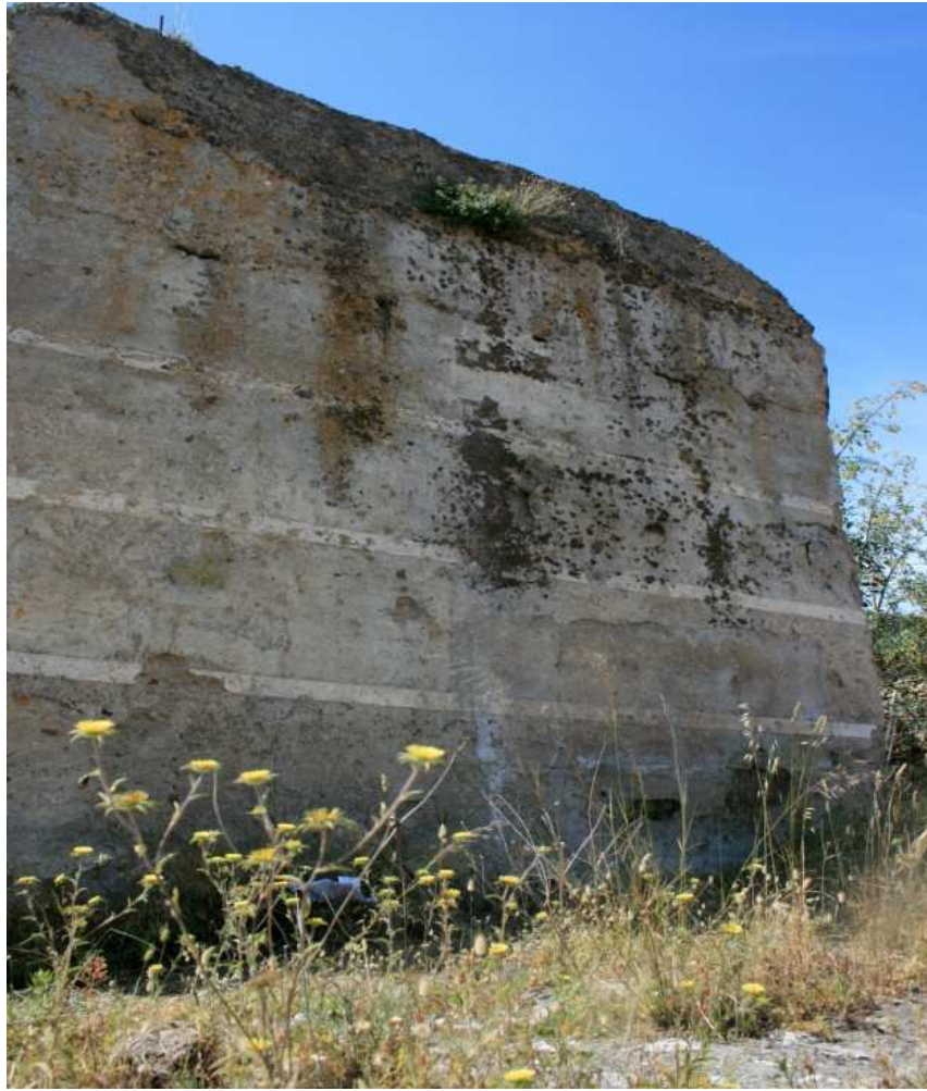
(4) façade nord de la Tour 13
