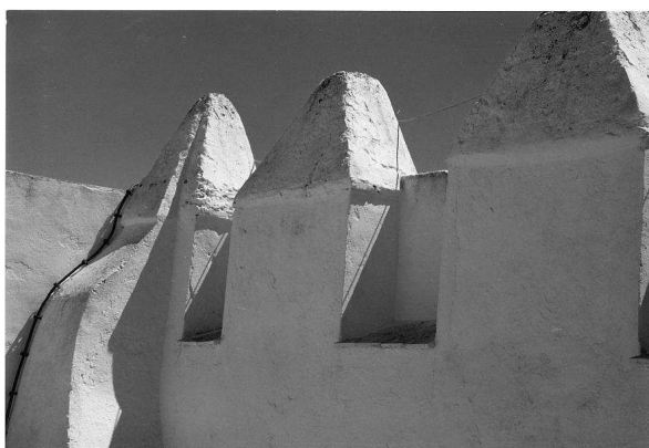
Coronamiento superior con merlones albardillados de un torreón de la cerca conservado entre el edificio del Ayuntamiento y el Hospital de San Juan de Dios.
