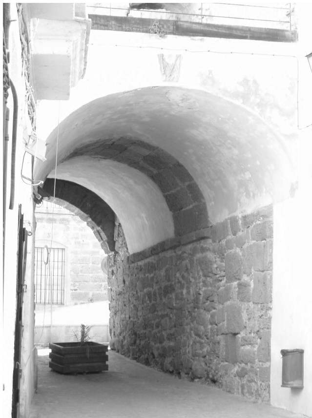
Vista actual desde el interior de la Puerta del Arrabal de Santa María.
