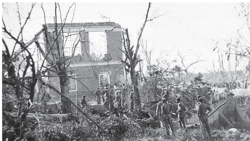
FIGURA 16. Derribo de la casa de las familias Palacios y Deudero, destruida por la explosión de 1947
