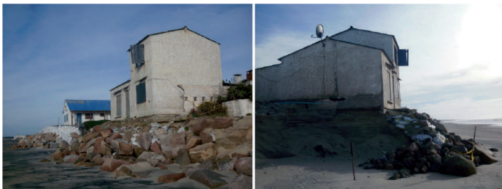
Figura 2. Edificação isolada pela governança local de Aguas Dulces (esq.) com detalhe de sua fundação evidenciada por processos erosivos (dir.) em projeto inapto à realidade geotécnica do substrato (dunas).
