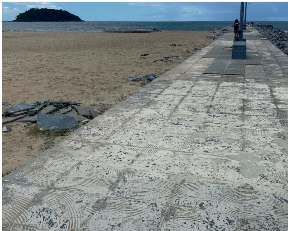
Figure 18. Degradação do trapiche da Praia Mansa, em Matinhos - Paraná.
