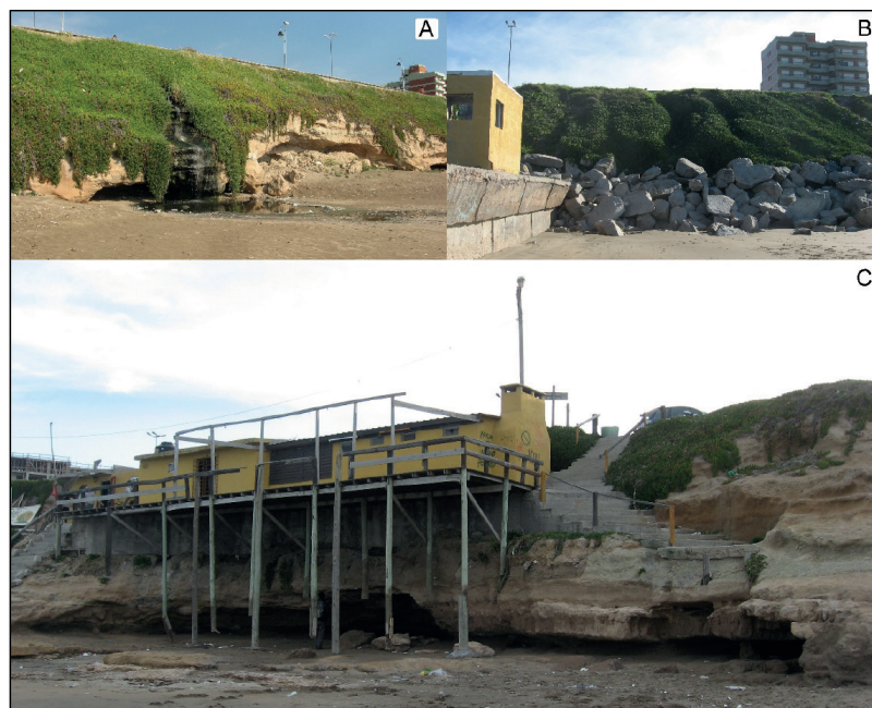
Figura 3. A) Cubierta vegetal, con desagüe pluvial; B) cubierta vegetal y enrocado; C) Construcción sobre el acantilado con escaleras de acceso a la playa.
