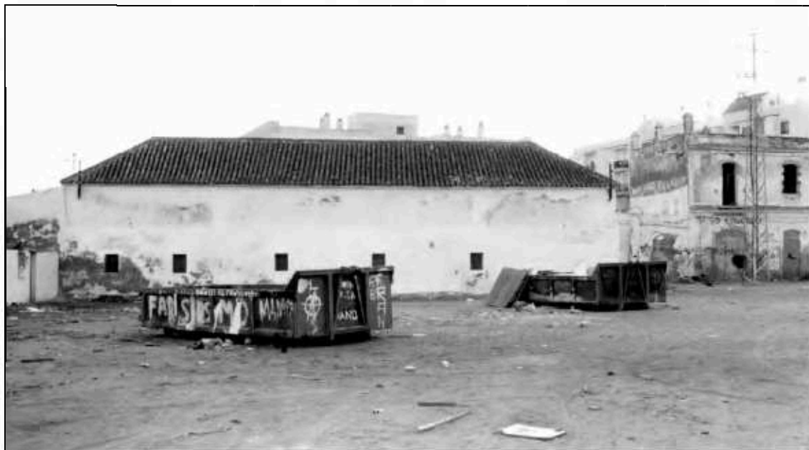
Figura 7b. Molino de marea de Saporito en San Fernando. El entorno del molino ha cambiado de forma radical. El caño de Saporito se ha rellenado y toda la base del molino, con sus arcos y compuertas, está enterrada. Foto L. Ménanteau, 02-10-1998.
