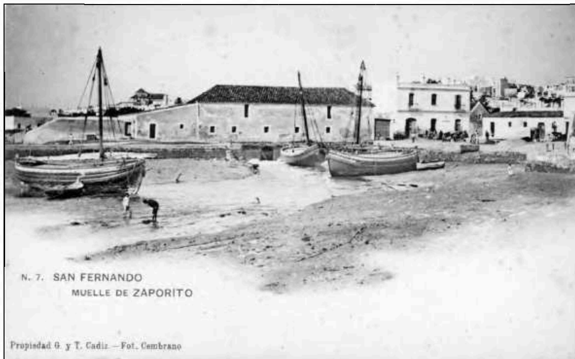
Figura 7a. San Fernando. Muelle de Zaporito. Se ve el molino desde la bahía con, en primer plano, el caño de Zaporito en bajamar con faluchos encallados. En el centro del molino, se ve un arco donde está la compuerta por la cual el agua entra en la caldera. La primera planta, con sus dos aperturas altas, corresponde al almacén de granos. A la derecha, muelle de Zaporito. Postal antigua hacia 1900, col. L. Ménanteau.
