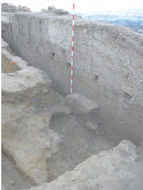
Figura 4. Muralla de tapial islámico.
