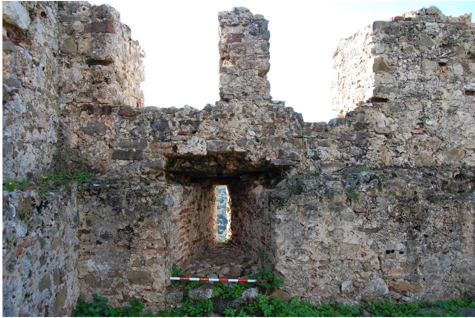
Figura 4. Vista interior de la torre: resalte y “saetera”.
