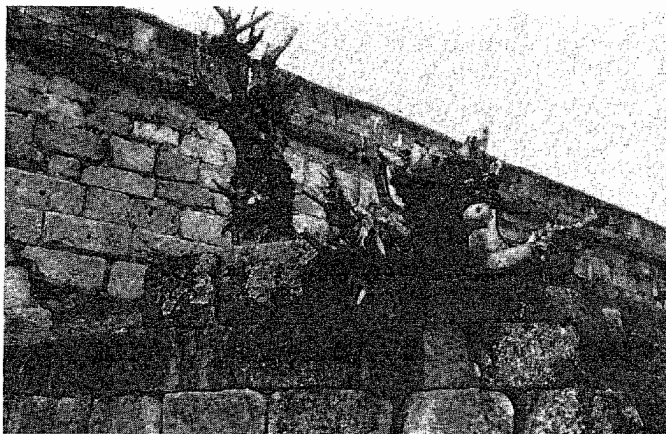
Foto 3. Puente romano sobre el río Ambroz. Guijo de Granadilla. (Cáceres). «Los efectos destructores de las plantas se centran en la expan- sión de las raíces...» (Díez García).
