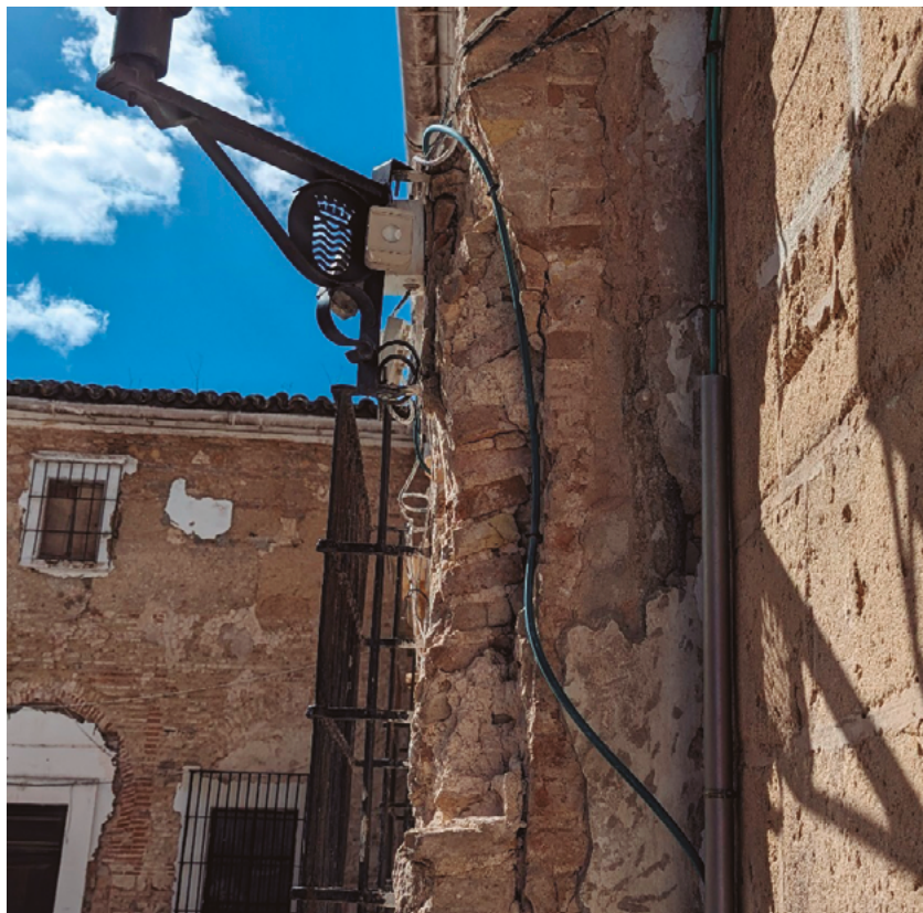
Figura 6. Jerez de la Frontera. Catedral. Casa del Abad. Arranque de arco de ladrillo. A la derecha, sillares de la torre tardogótica
