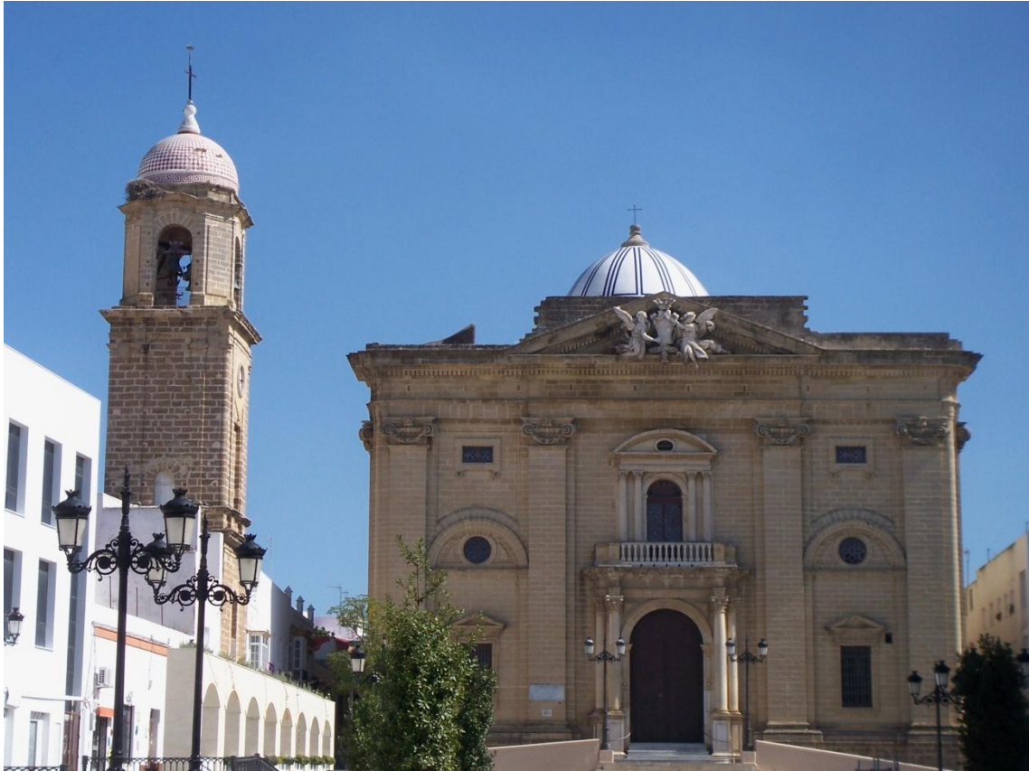
Imagen 1. Fachada principal y Torre del Reloj
